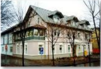
Pošta Bled ter Knjižnica Blaža Kumerdeja v sosednji stavbi
